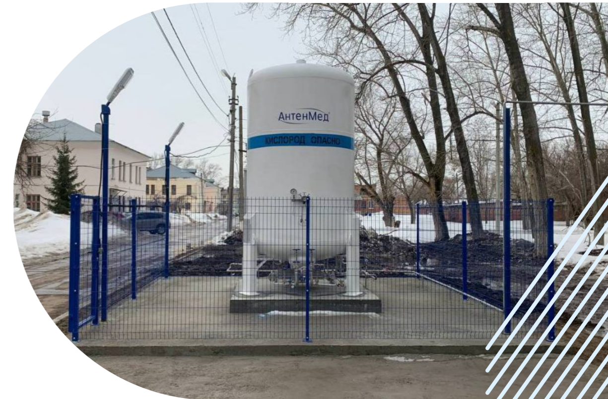
Поставка и монтаж кислородно-газификационной станции для ГБУЗ СО «Отраденская городская больница»
